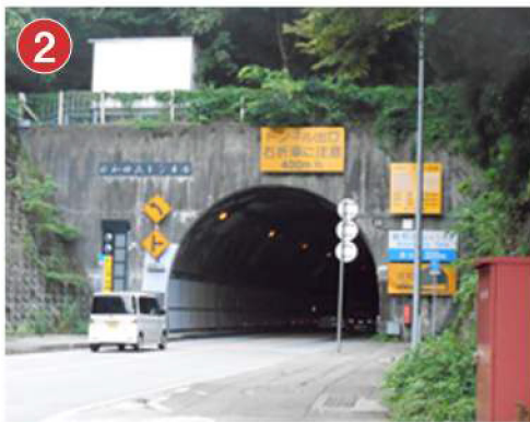
② 新和田山トンネル
